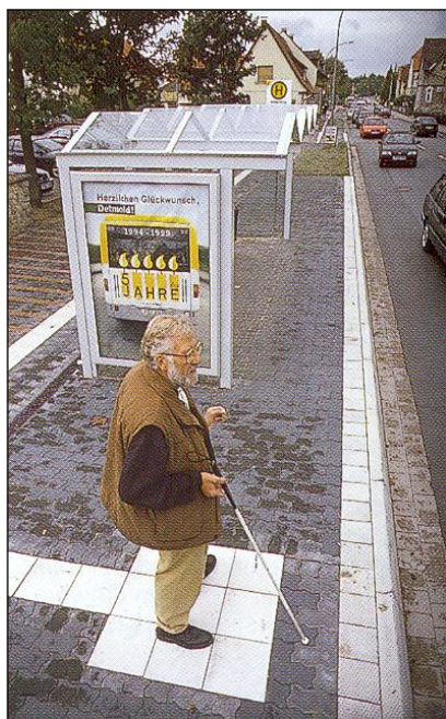
Obr. 1 a 2 Příklad navádění zrakově postižených cestujících v nástupním prostoru zastávky
