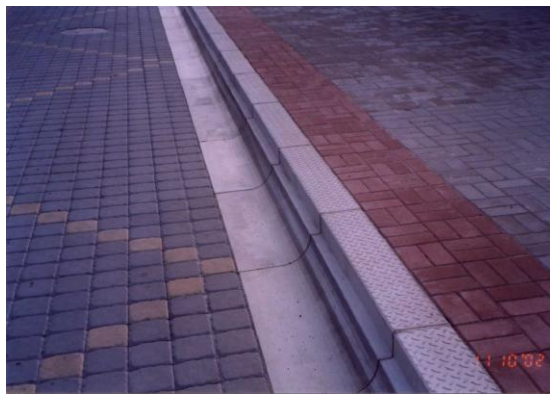
Obr. 36 a 37 „Časový ostrůvek“ se SZZ (Praha, Pražská tržnice) a tzv. Kasselský obrubník, umožňující těsné najetí autobusů a trolejbusů k zastávkové hraně
