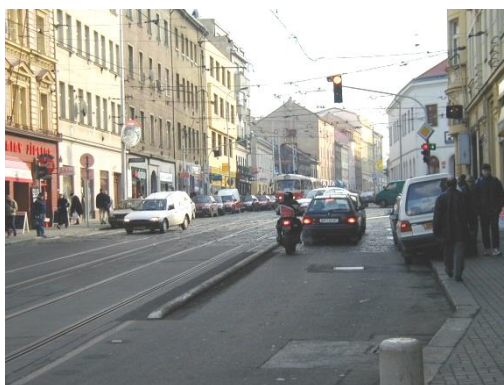
Obr. 29 Podélné prahy pro fyzické oddělení tramvajové trati (Praha, Nuselská)
