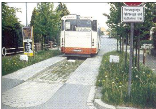
Obr. 29 Podélné prahy pro fyzické oddělení tramvajové trati (Praha, Nuselská)
